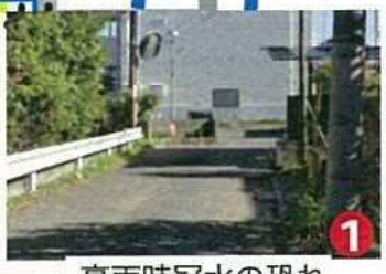
豪雨時冠水の恐れ
