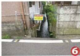
ガードレールがなく危険
