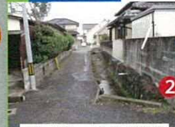
ガードレールなく危険
